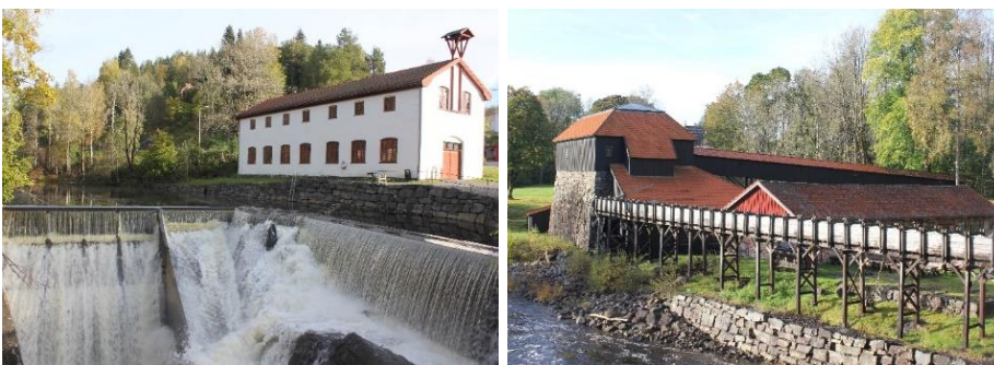
Storelva og dammen er avgjørende i produksjonsprosessen. Vannet føres i renner inn til vannhjulene.
