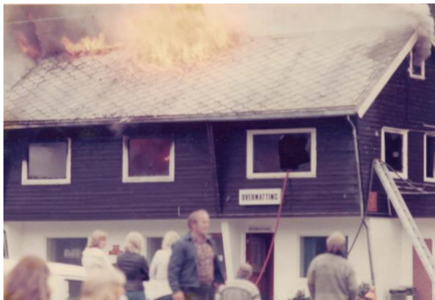
390 Brannen går gjennom taket
