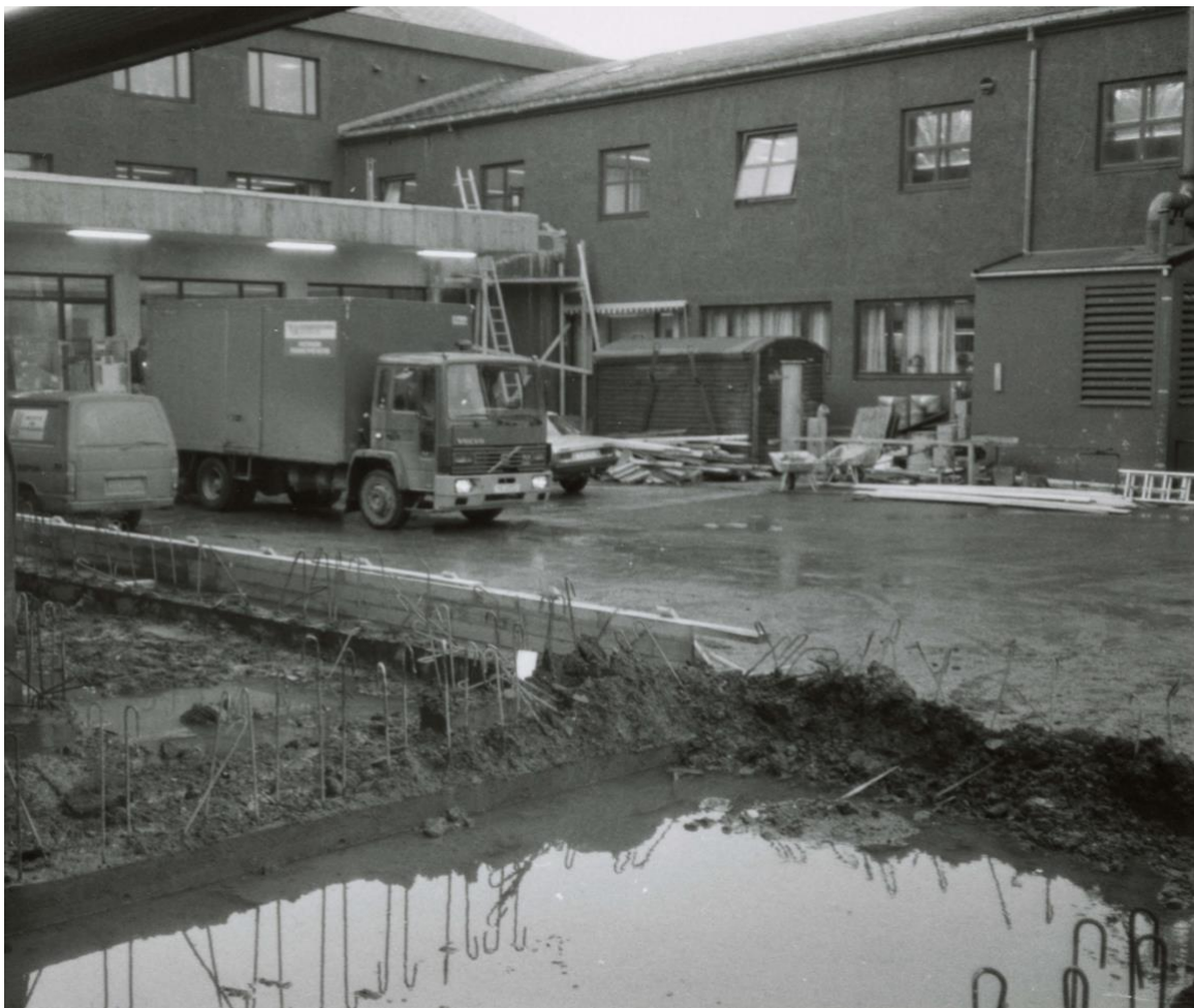
249 Bakgården på Bodø postkontor. Tilbygg/tak over lasterampen bygges.
