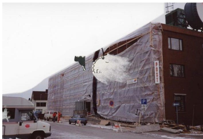
94 Bodø postkontor pakket i plast ifbm renovering
